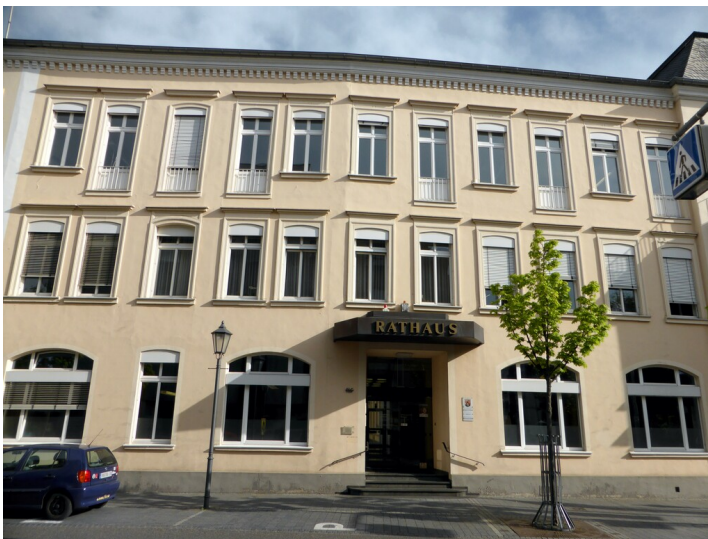
Rathaus der Stadt Bad Neuenahr-Ahrweiler (2019) Fotograf/Urheber: Elmar Knieps
