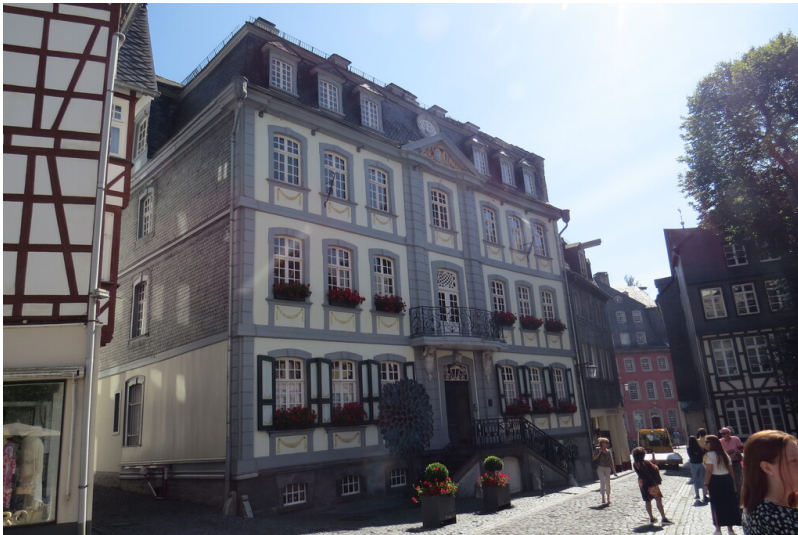
Haus Troistorff in der Laufenstraße in Monschau (2024) Fotograf/Urheber: Gabriele Harzheim
