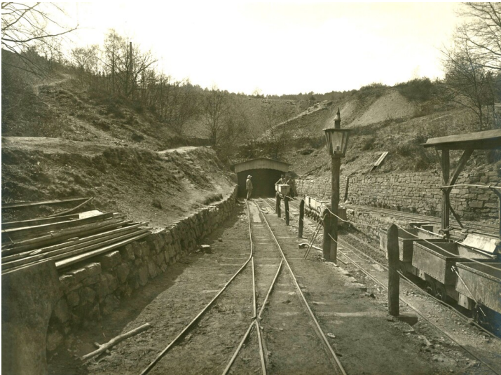
Der Auguststollen bei Steinenbrück (um 1890). Fotograf/Urheber: unbekannt
