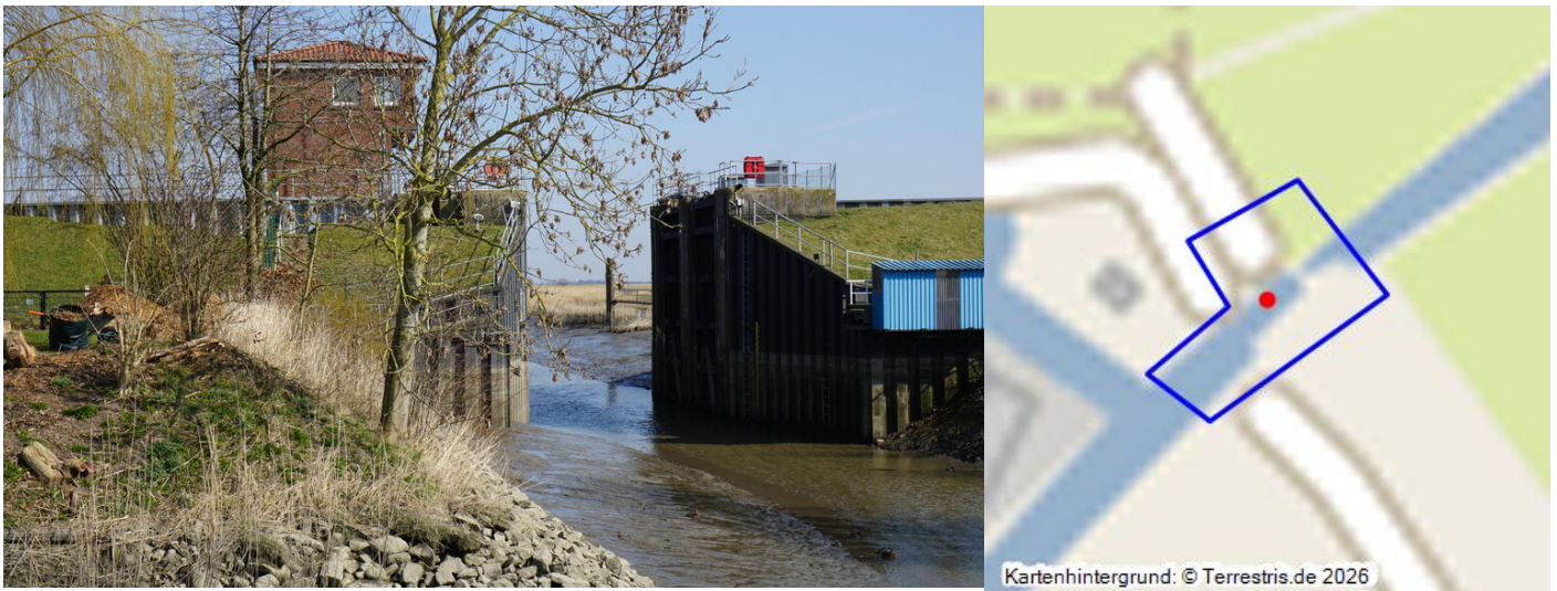
Freiburg (Elbe), Sturmflutsperrwerk (2025) Fotograf/Urheber: Claus Weber
