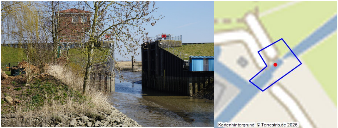
Freiburg (Elbe), Sturmflutsperrwerk (2025) Fotograf/Urheber: Claus Weber
