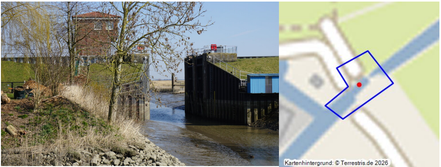
Freiburg (Elbe), Sturmflutsperrwerk (2025) Fotograf/Urheber: Claus Weber
