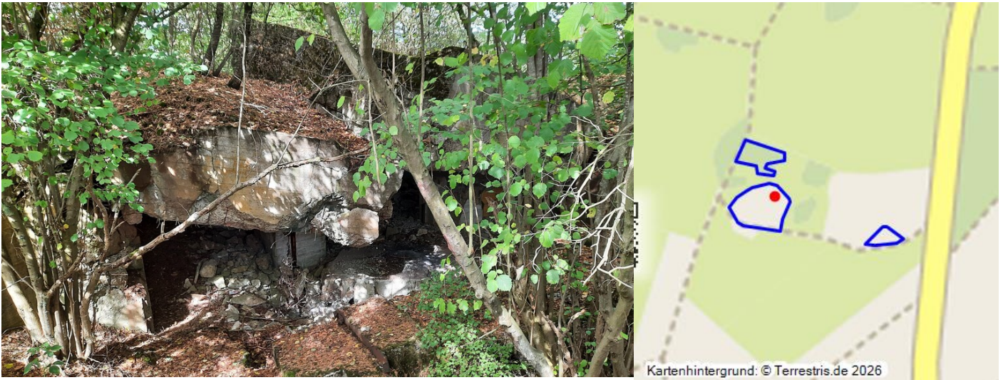
gesprengter Bunker der Luftverteidigungszone West bei Bouderath (2022) Fotograf/Urheber: Martina Gelhar
