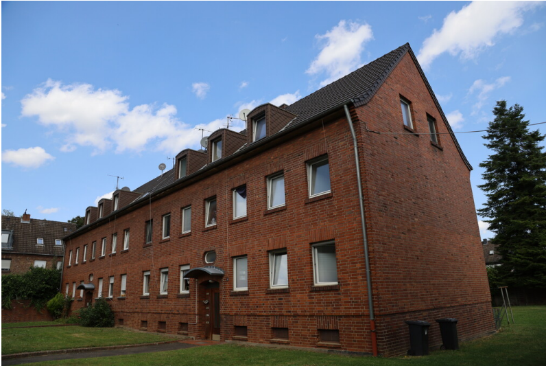
Mehrfamilienhäuser der Siedlung Am Lindchen (2024) Fotograf/Urheber: Nicole Schmitz
