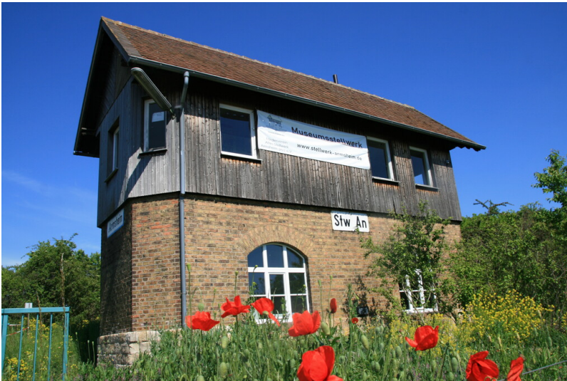
Museumsstellwerk Armsheim Nord (2025) Fotograf/Urheber: Förderverein Altes Stellwerk Armsheim (An) e.V.
