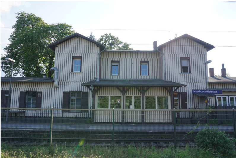
Bahnhof Meerbusch-Osterath. Gleisseite (2018) Fotograf/Urheber: Claus Weber
