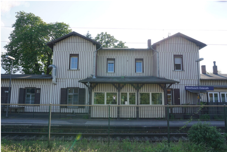
Bahnhof Meerbusch-Osterath. Gleisseite (2018) Fotograf/Urheber: Claus Weber
