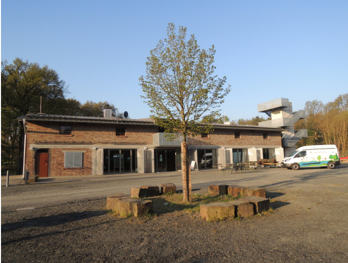
Turmhof in der Wahner Heide nach dem Umbau (2017) Fotograf/Urheber: unbekannt
