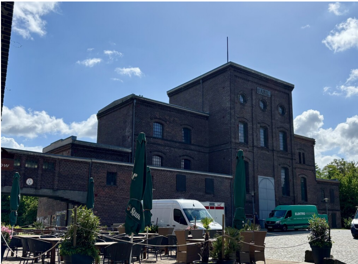
Schachtgebäude mit Malakowturm der Zeche Carl (2025) Fotograf/Urheber: Angelika Mikusz
