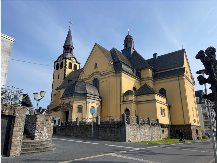
Gesamtansicht von der Rheinallee (2025) Fotograf/Urheber: Exner, Urs
