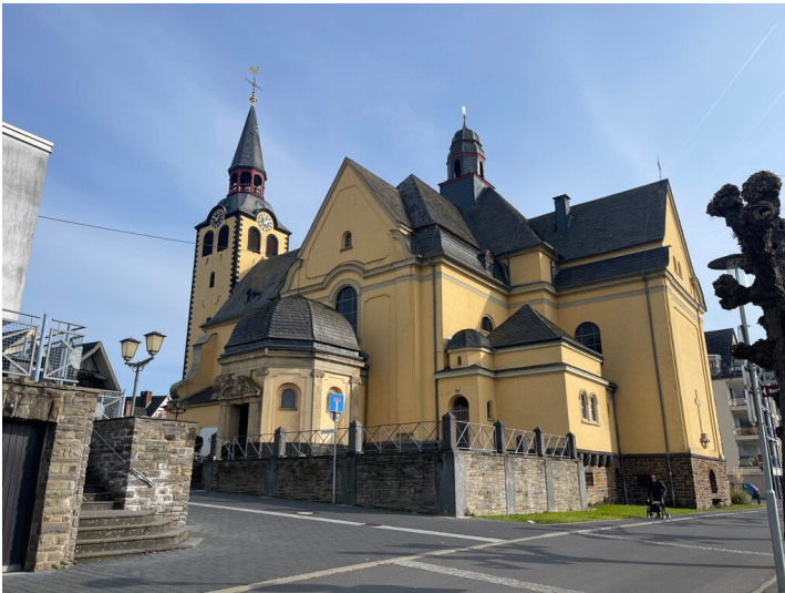
Gesamtansicht von der Rheinallee (2025) Fotograf/Urheber: Exner, Urs
