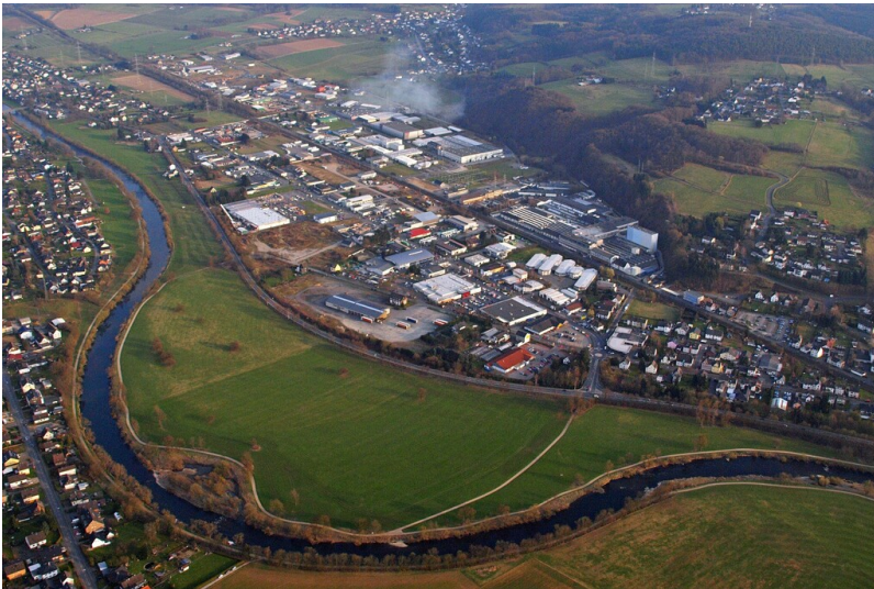
Luftaufnahme des Gewerbegebiets in Eitorf mit der Sieg im Vordergrund (2012). Hinter der querenden Bogestraße u.a. die Werke der ZF Friedrichshafen AG (vormals Boge & Sohn) und der Weco Pyrotechnische Fabrik GmbH. Fotograf/Urheber: Wolkenkratzer
