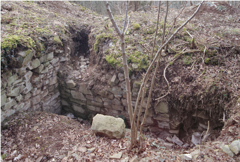
Mauerzug in der südlichen Oberburg (2006) Fotograf/Urheber: Uwe Welz
