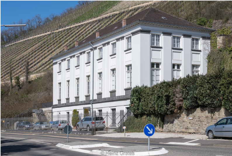
Neues Brunnenhaus in Heppingen (2021) Fotograf/Urheber: Heinz Grates
