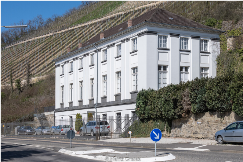
Neues Brunnenhaus in Heppingen (2021) Fotograf/Urheber: Heinz Grates
