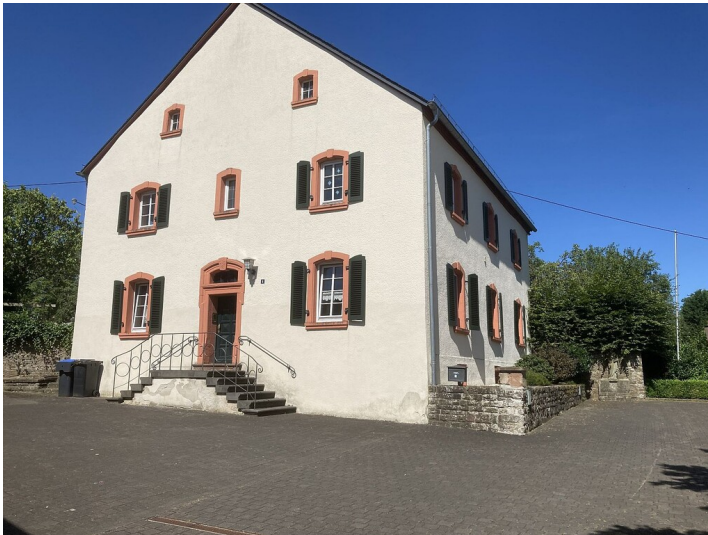
Das Pfarrhaus in der Kirchstraße 8 in Oberkail (2023) Fotograf/Urheber: Erich Schäfers
