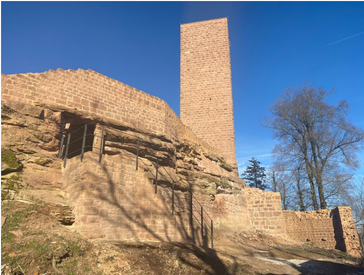
Blick von Süden auf die Scharfenberg (2025) Fotograf/Urheber: Verein Südliche Weinstraße Annweiler
