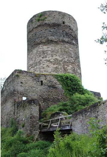
Der Bergfried der Unterburg von Burg Stahlberg bei Bacharach (2024) Fotograf/Urheber: Michael Klemm
