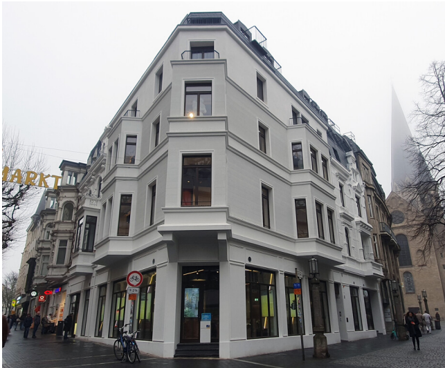
Außenaufnahme des Paul-Clemen-Museums im P26 an der Ecke zwischen Poststraße und In der Sürst in Bonn (2025). Fotograf/Urheber: Jana Schulte
