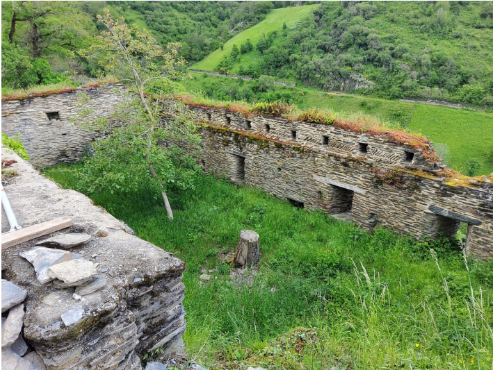
Blick in den Palasbereich der heutigen Burgruine Stahlberg nahe Bacharach (2024) Fotograf/Urheber: Florian Weber
