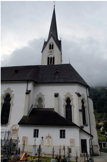
Pfarrkirche Mariä Himmelfahrt in Sillian (Osttirol) (2024) Fotograf/Urheber: Karl Peter Wiemer
