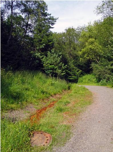
Ein Kanalschacht fasst die Stelle ein, an der das Grubenwasser aus dem Wetterschacht der Grube Blücher zu Tage tritt. Der Wasseraustritt wurde in den 1950er Jahren beim Wegebau angeschnitten (2024).
