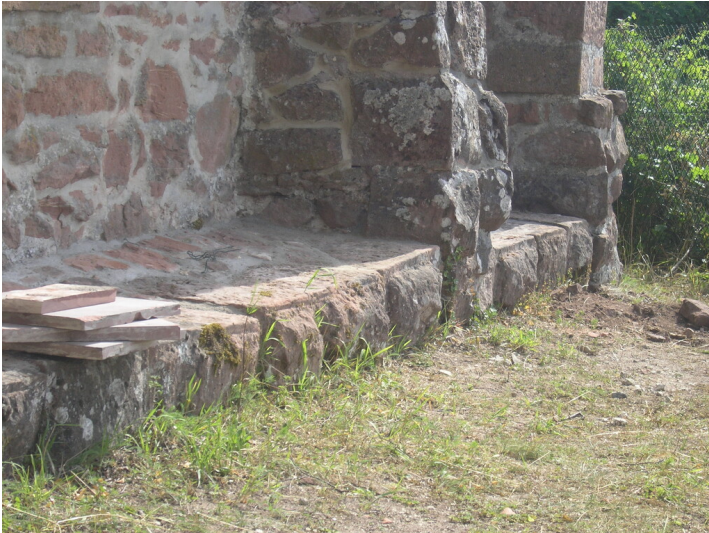
Buckelquader am Sockel der Südwand (2004) Fotograf/Urheber: Dieter Barz
