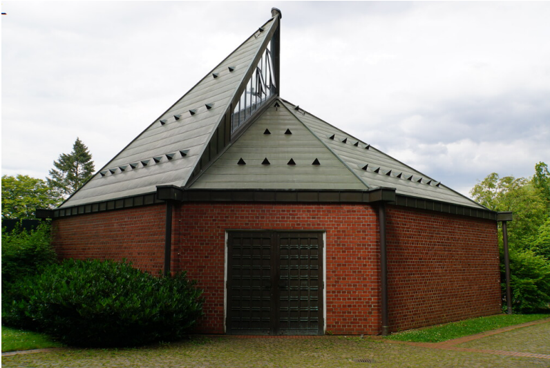
Neue Trauerhalle Nordfriedhof Köln-Weidenpesch(2024) Fotograf/Urheber: Malte Hennes
