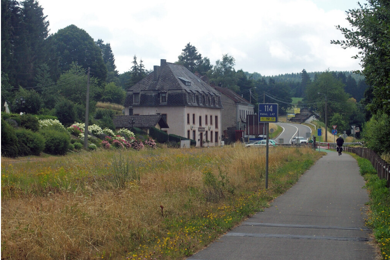
Bahnhof Lengeler (2022) Fotograf/Urheber: Karl Peter Wiemer
