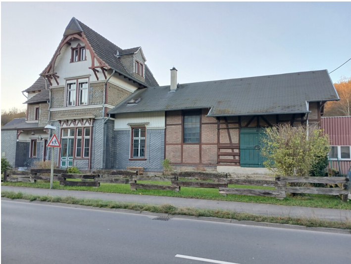
Das Empfangsgebäude und der Güterschuppen des Bahnhofs Immekeppel von der Straßen-/Landseite im Süden (2024). Fotograf/Urheber: Alexander Kierdorf
