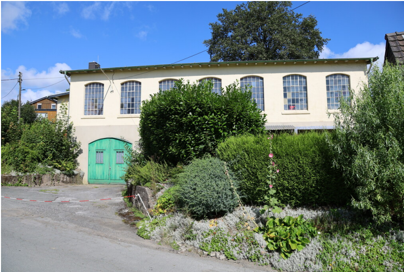
Gebäude der ehemaligen Bandweberei Frielinghausen (2024) Fotograf/Urheber: Marius Röhr
