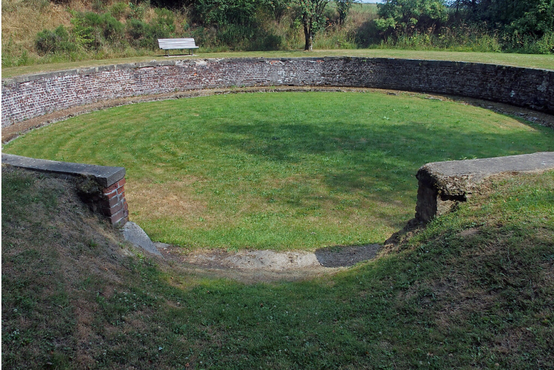
Ehemalige Lokomotiven-Drehscheibe bei Born (2022) Fotograf/Urheber: Karl Peter Wiemer
