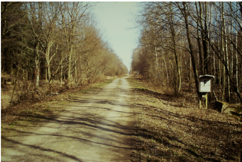
Bahntrasse Düren - Neuss bei Eitzweiler/Morschenich mit Fernsprecher (2005) Fotograf/Urheber: Horst Haarich
