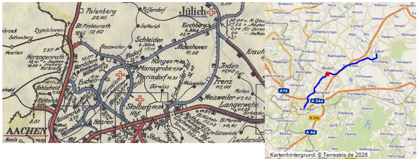
Bahnstrecke Aachen Nord - Jülich (1917) Fotograf/Urheber: Unbekannt
