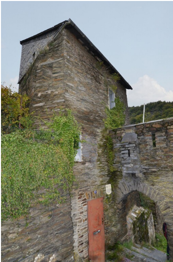
Der Leiterberger Turm, auch Pilippineburg genannt, liegt in den Weinbergen in Kaub (2024) Fotograf/Urheber: Hermann Knecht
