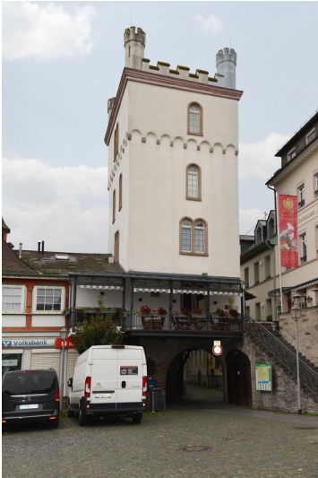
Der Mainzer Torturm führt von der Zollstraße aus in die Metzgergasse in Kaub (2024) Fotograf/Urheber: Hermann Knecht
