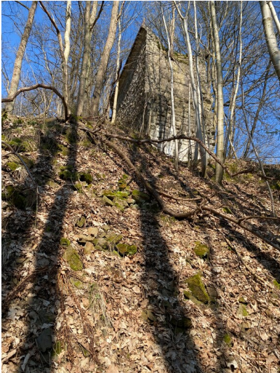
Bahndamm und Reste der Haarmannbrücke der Kleinbahn Bielstein-Waldbröl (2024) Fotograf/Urheber: Nicole Schmitz
