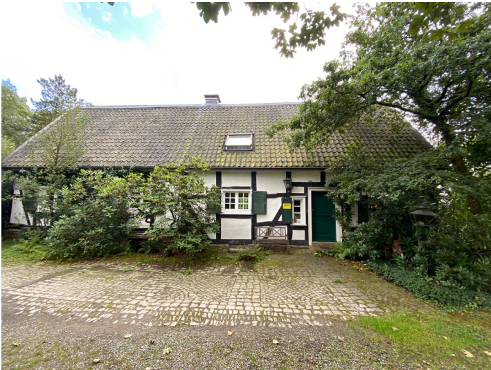
Wirtschaftsgebäude des Pfarrgutes Windhausen (2024) Fotograf/Urheber: Nicole Schmitz
