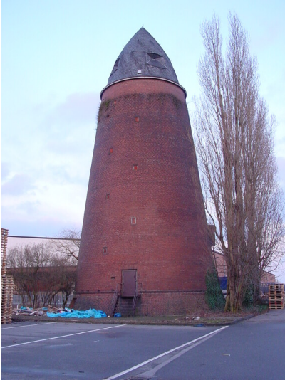
Der Winkelturm in Köln-Niehl, ein im Jahr 1940 erbauter Luftschutzturm der Bauart "Winkel" an der Neusser Landstraße (2001). Fotograf/Urheber: Ivo Schenk
