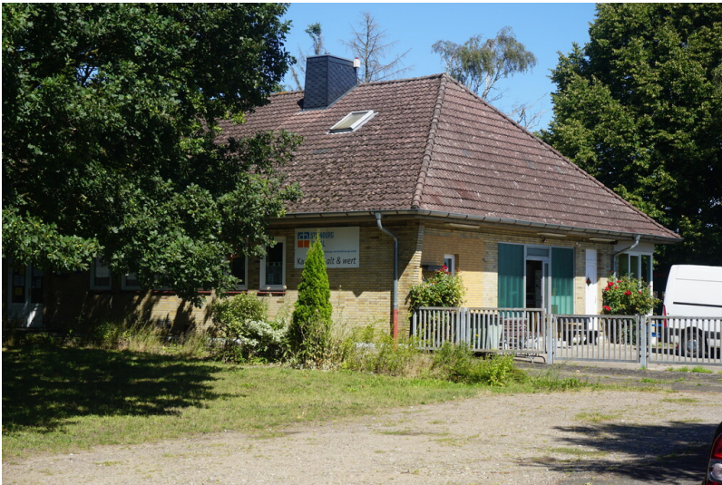
Bahnhof Wilster (2024). Empfangsgebäude von 1961 Fotograf/Urheber: Claus Weber
