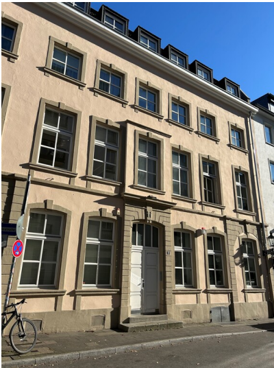
Die Fassade des denkmalgeschützten Gebäudes Neubrückestraße 12 in der Düsseldorfer Altstadt, 1967-1976 der "Club Creamcheese" (2024). Fotograf/Urheber: Ines Müller
