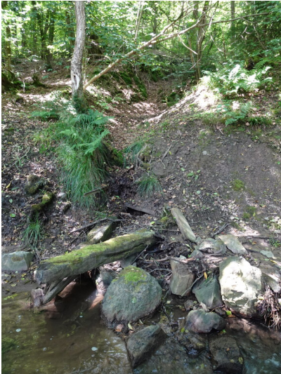
Das verstürzte Mundloch des tiefen Ehrenfeldstollens direkt am Volbach ist noch als Geländemulde (Pinge) deutlich sichtbar (2024). Fotograf/Urheber: Peter Schönfeld
