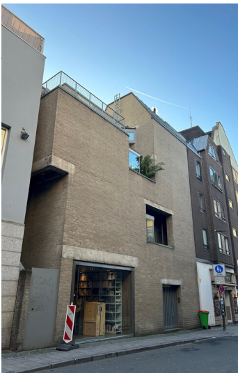
Fassade des Galeriehauses "Schmela Haus" von Aldo van Eyck in der Düsseldorfer Altstadt, Mutter-Ey-Straße 3 (2024) Fotograf/Urheber: Ines Müller
