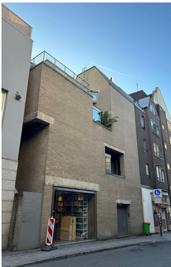
Fassade des Galeriehauses "Schmela Haus" von Aldo van Eyck in der Düsseldorfer Altstadt, Mutter-Ey-Straße 3 (2024) Fotograf/Urheber: Ines Müller
