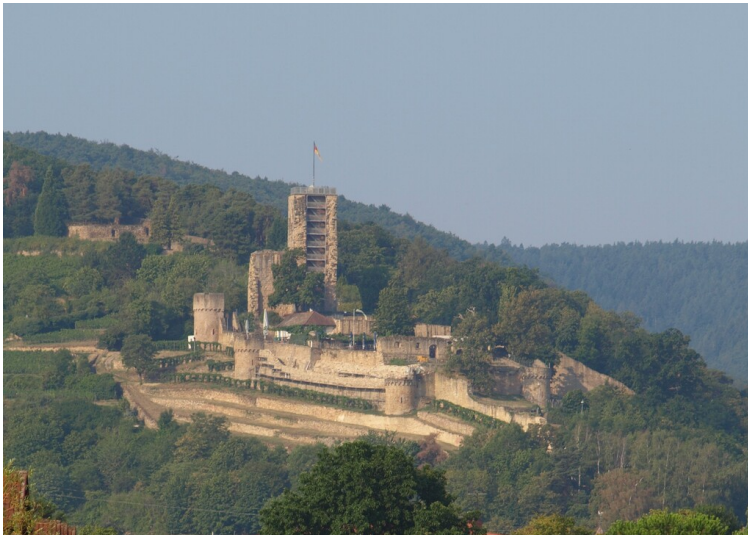
Gesamtansicht von Südost Fotograf/Urheber: Gröne
