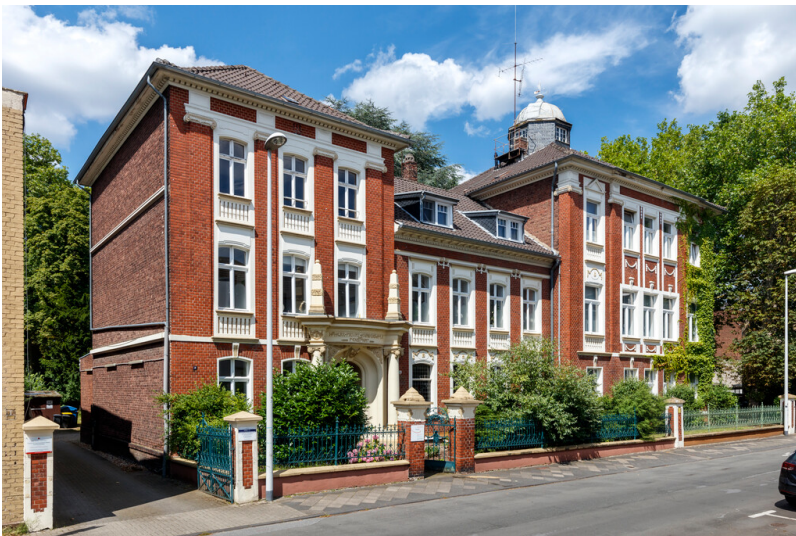
Die Rektoratsschule an der Kolpingstraße in Hilden, auf dem Dach rechts die 1908 eingerichtete Sternwarte (2024). Fotograf/Urheber: Rainer Hotz
