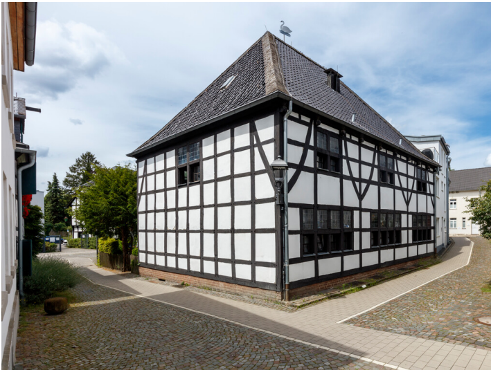
Das Haus zum Schwanen in der Eisengasse in Hilden, Ansicht der nach Südwesten und Südosten zeigenden Fassaden (2024). Fotograf/Urheber: Rainer Hotz
