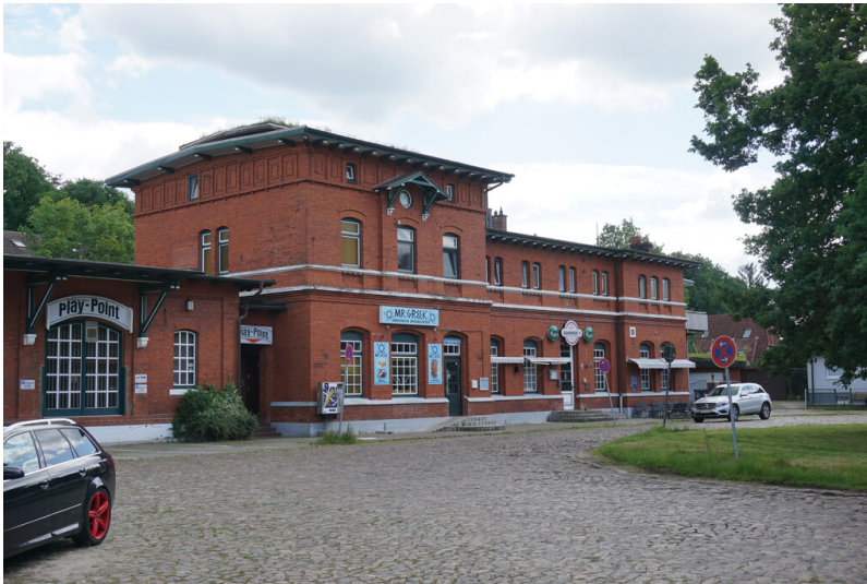
Bahnhof Trittau, Empfangsgebäude, Stadtseite (2024) Fotograf/Urheber: Claus Weber
