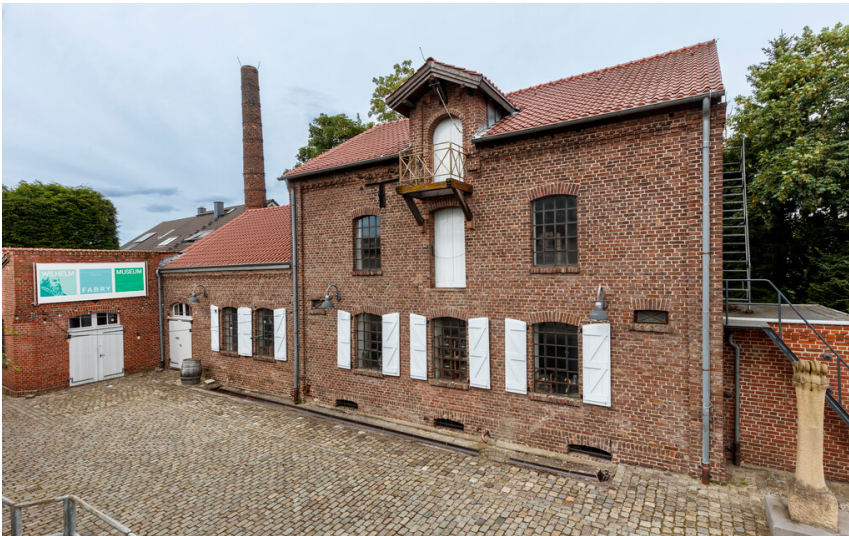
Alte Kornbrennerei Vogelsang am Wilhelm-Fabry-Museum in Hilden (2024): Ansicht der alten Brennerei von Westen aus gesehen. Fotograf/Urheber: Rainer Hotz
