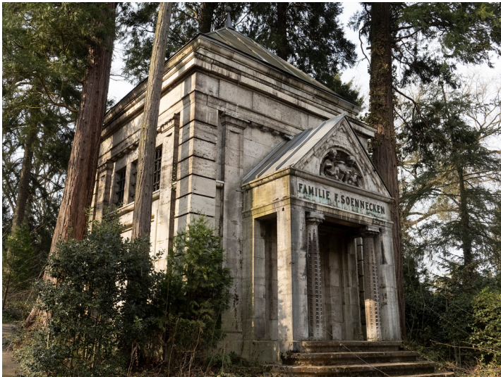
Das Soennecken-Mausoleum Fotograf/Urheber: Biostation Bonn / Rhein-Erft; Monika Hachtel
