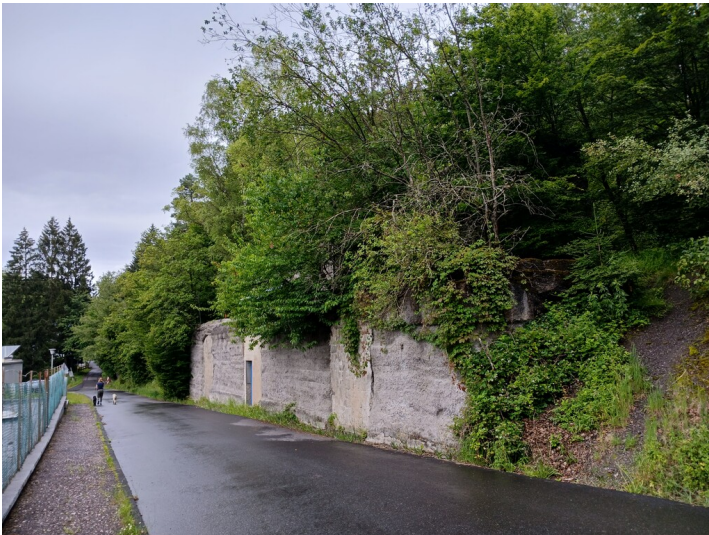
Die Ende des 19. Jahrhunderts errichtete Aufbereitung (Zerkleinerungs- und Sortieranlage) des Erzbergwerks Berzelius ruht auf Fundamenten aus massivem Stampfbeton, Ansicht von Süden (2024). Fotograf/Urheber: Alexander Kierdorf
