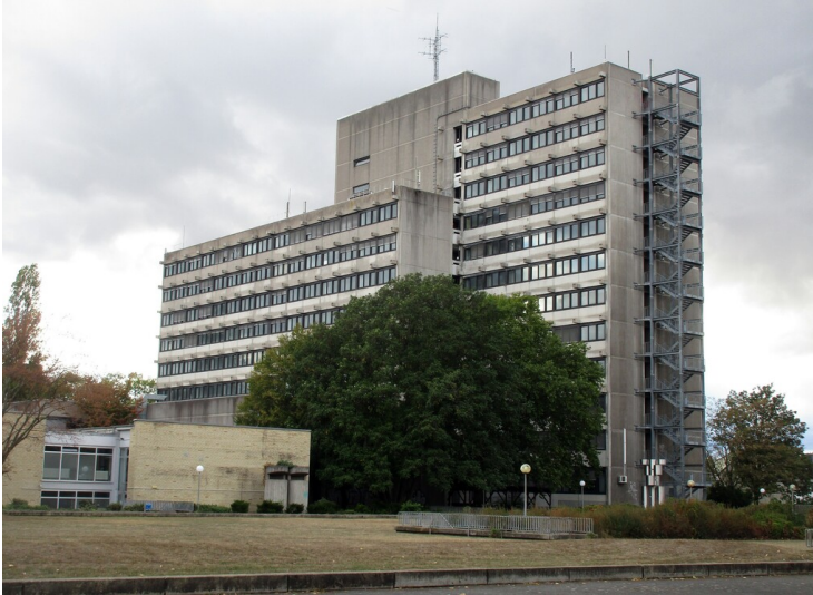
Das unter anderem als Universitätsgebäude der pädagogischen Fakultät genutzte Hochhaus in Bonn-Castell (2020), Ansicht von Westen her. Fotograf/Urheber: Franz-Josef Knöchel
