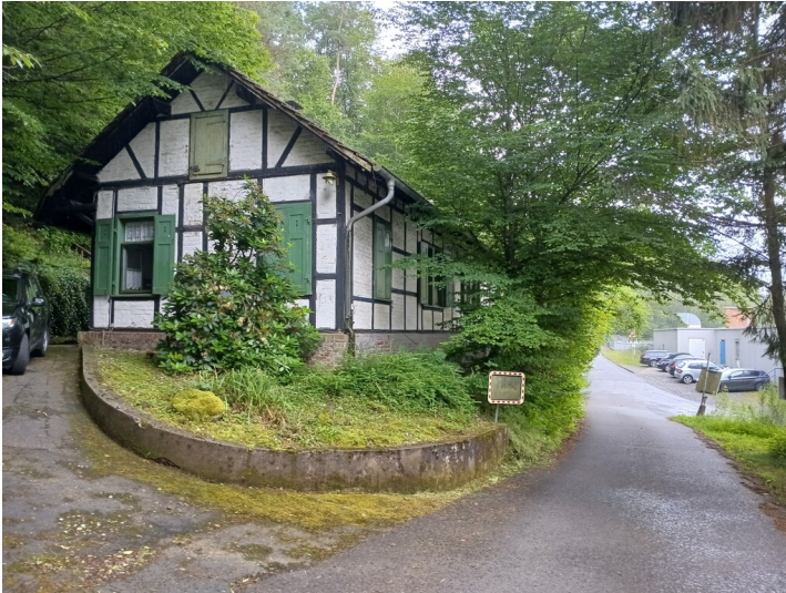
Das ehemalige Zechenhaus (Zentralbüro) der Grube Berzelius war vermutlich zunächst ein Kesselhaus; Ansicht von Norden (2024) Fotograf/Urheber: Alexander Kierdorf
