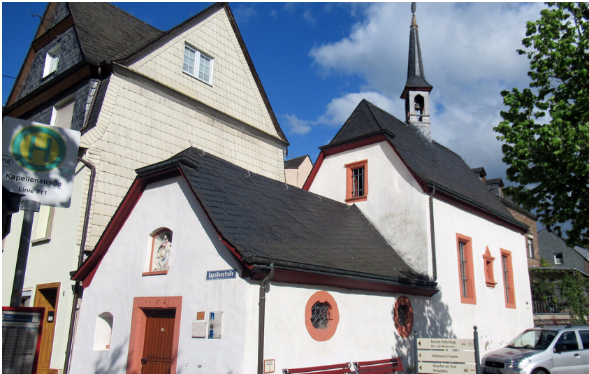
Ansicht von der Moselstraße (2024) Fotograf/Urheber: Michael Grün
